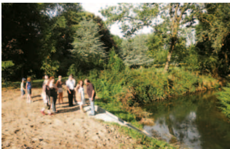
Hier, achteraan De Polder, komt de nieuwste collector voor de opvang van regenwater uit in de Grote Gete.
